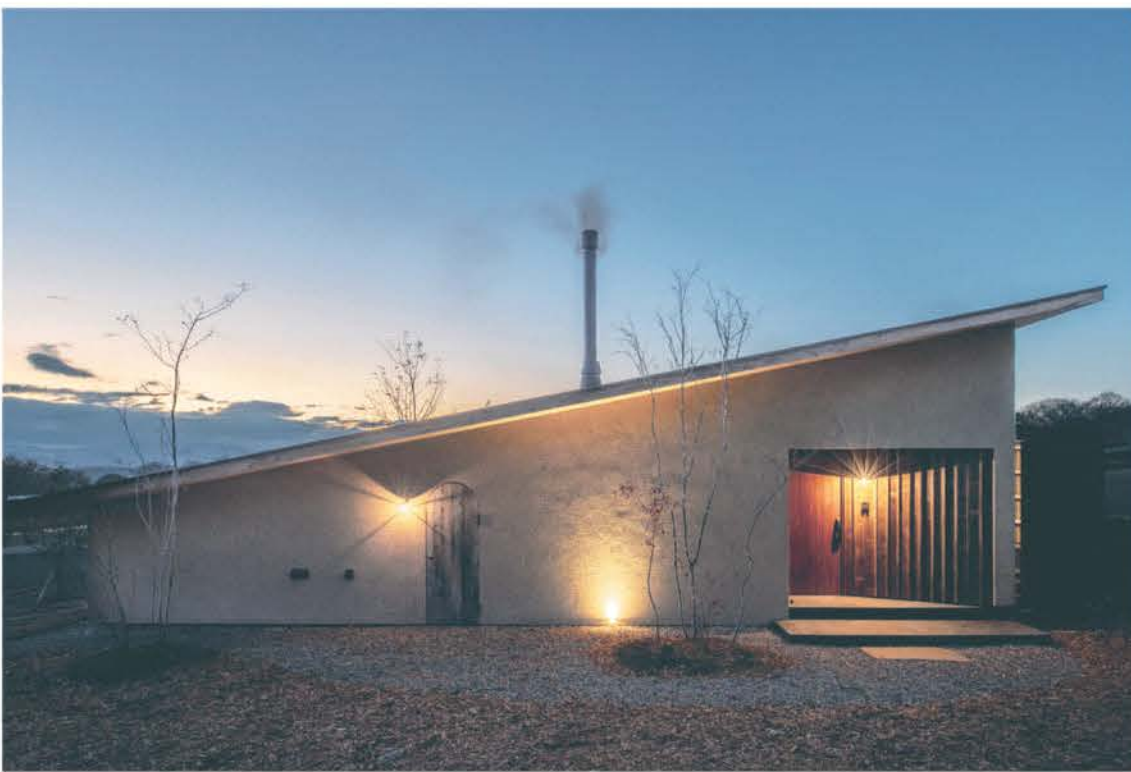
オランダ語で「土」を意味する「AARDE (アルデ)」は、黒モルタルで仕上げた内部の土間や薪ストーブのある暮らしを提案する。地面に向かって傾斜するような屋根も特徴的で目を引く。
