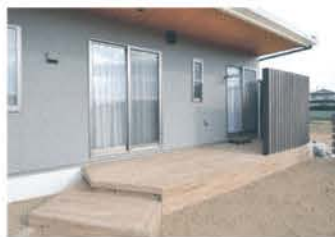
深い軒に覆われた木目のタイルデッキ。芝を張る予定の庭先とリビングをつなぐ
