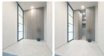
■ 玄関ホールのリブパネルがウオークインクローゼットの隠し扉に(右)
