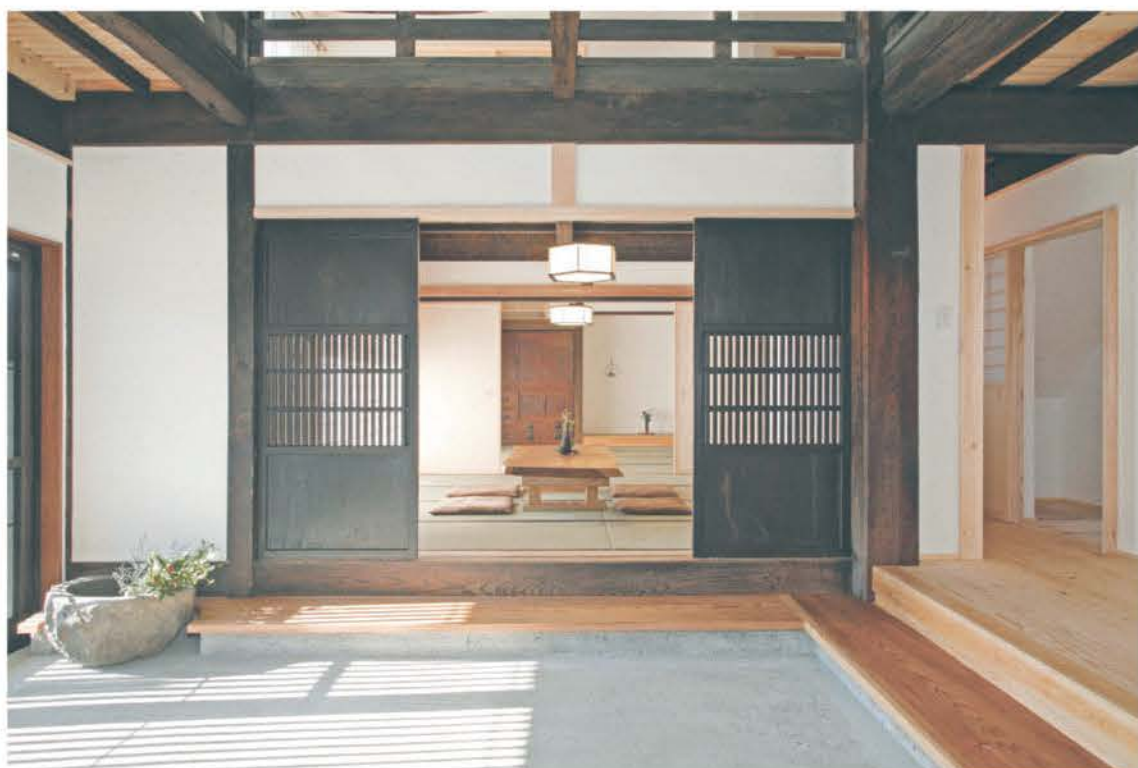
築150年の家を現代に住み継ぐ新旧が調和する古民家再生。養蚕農家だった建物の骨組みだけを残し全面大規模改修を行った。ゆったりとした吹き抜けの玄関土間。歴史を刻む古材や既存の建具が生かされ、真っ白な漆喰壁や新たな無垢材とのコントラストが美しい。
