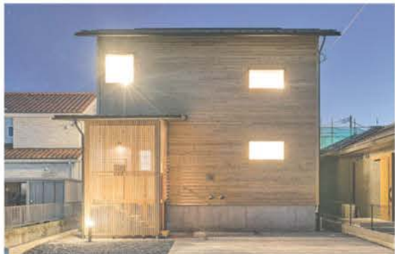
■ 経年変化で深い味わいを楽しめる群馬県産材の杉板外壁
