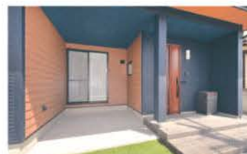
雨や日差しを遮る深い軒に覆われて多目的な利用が可能
