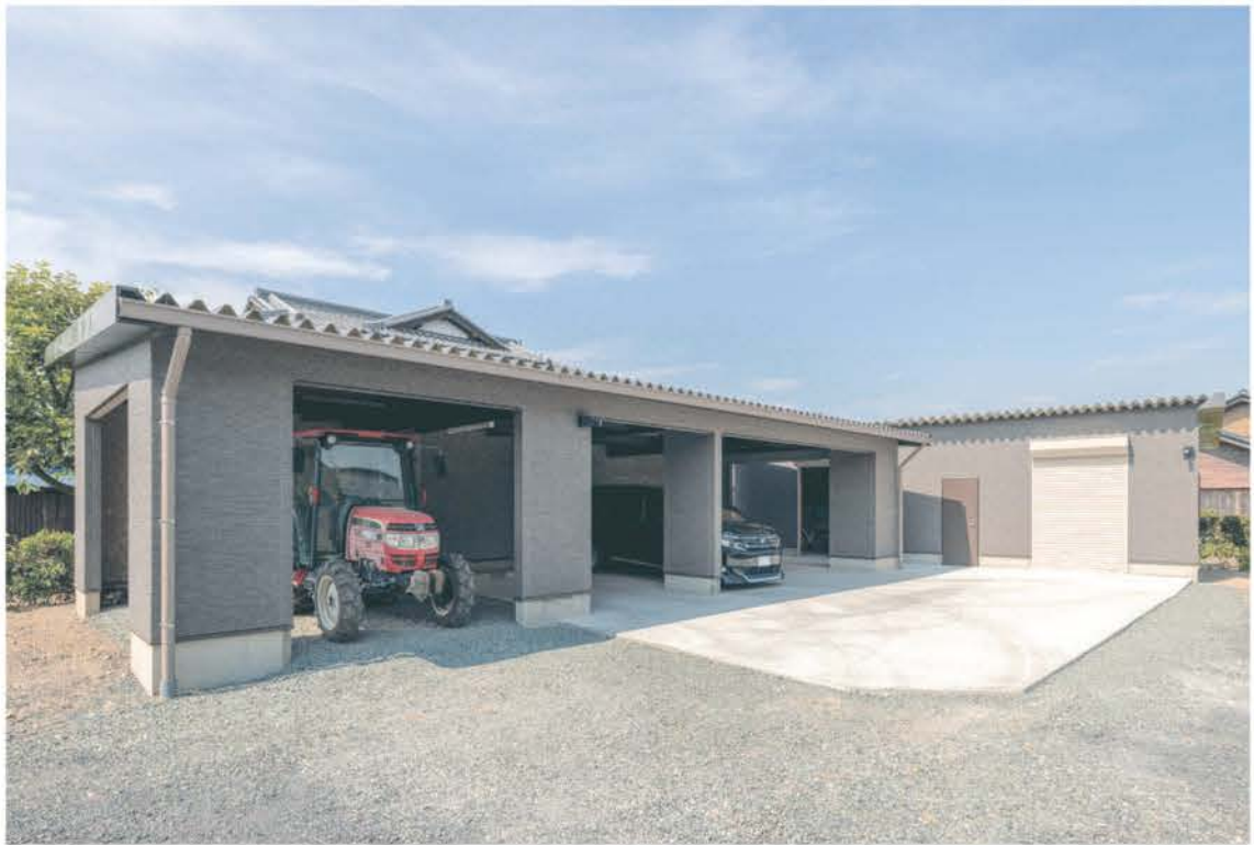
維持管理の大変だった明治時代に造られた蔵を解体し、広い敷地を生かして車3台とトラクターを1台収納できる大きなガレージを建てた。トラクター置場は砂利を敷き、車の下はコンクリート敷き。ガレージの奥の広い倉庫も同時に施工。
