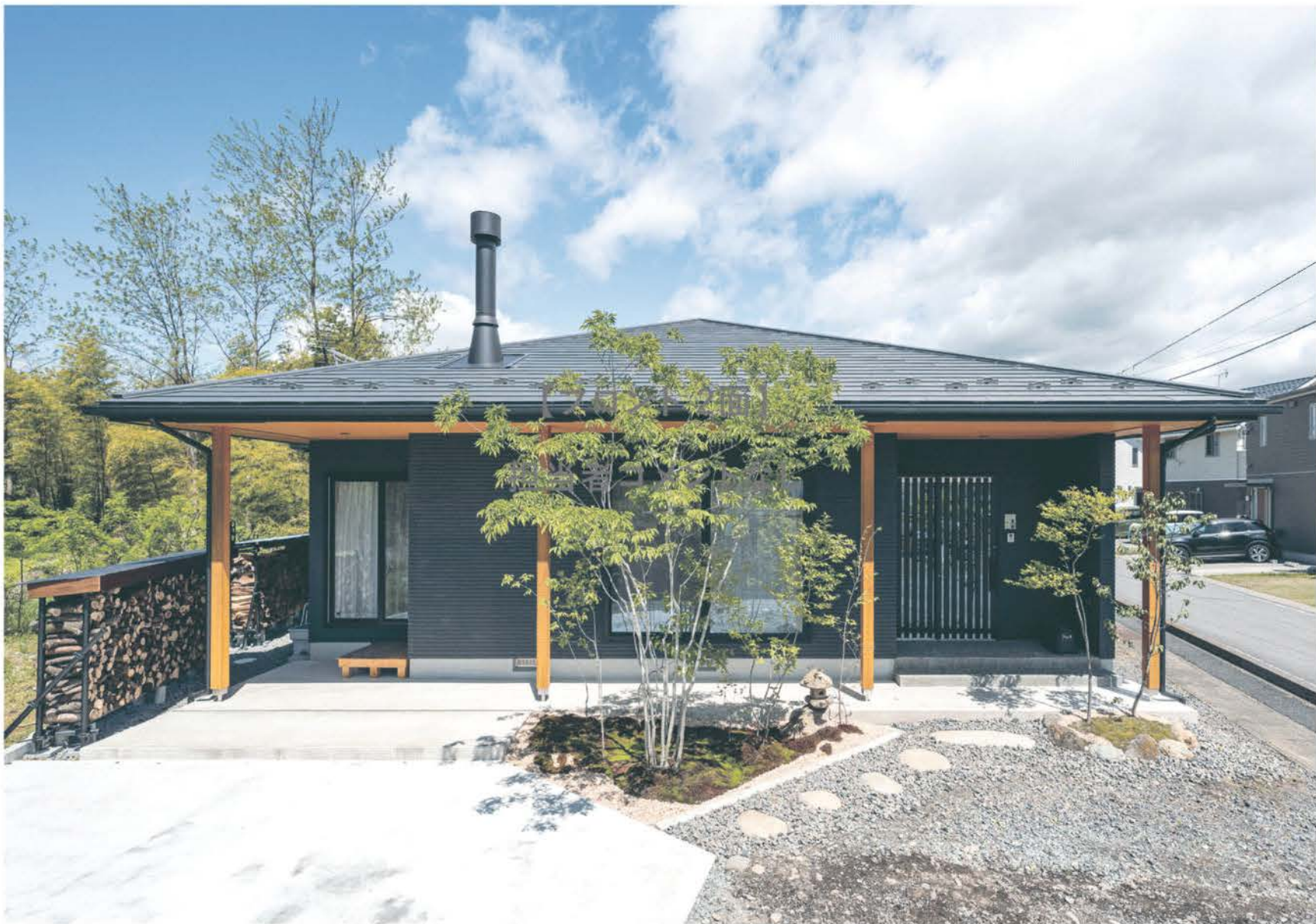
寄棟屋根に薪ストーブの煙突が伸びる平屋の外観。深い軒を支える柱と軒天の木部が黒い外壁に映える。
