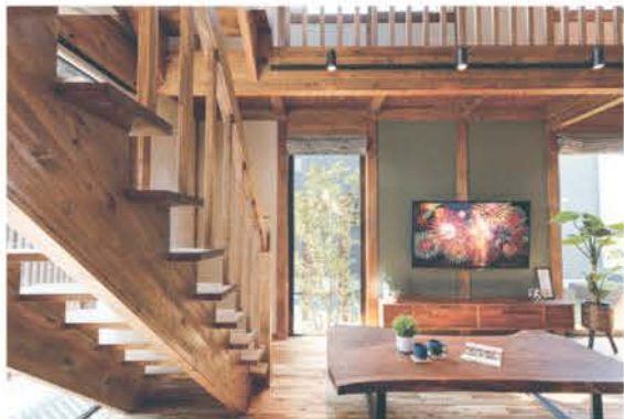
■ リビングの吹き抜けにある木製のスケルトン階段が階層をつなぐ
