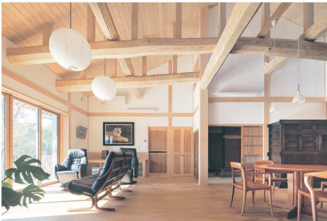
厳選した国産の良材が存分に生かされ、自然素材に満たされた心地いいリビング。高さのある勾配天井の大空間に、ダイナミックな梁丸太現しや檜8寸角の大黒柱が映える。漆喰の真壁造りと手づくりの家具や建具が調和する杉内建設の得意とする家づくり。
