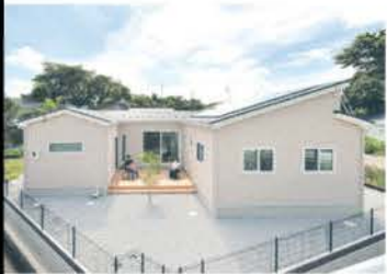
中庭のあるコの字型の平屋。中庭はタイルデッキにし、バーベキューやプール遊びが楽しめる
