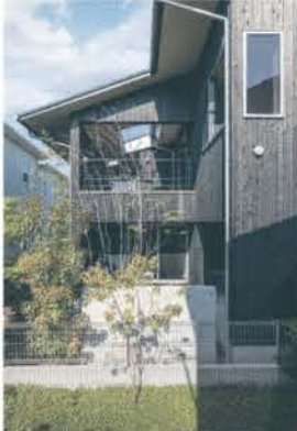
■ 焼杉の外壁が植栽と調和する
