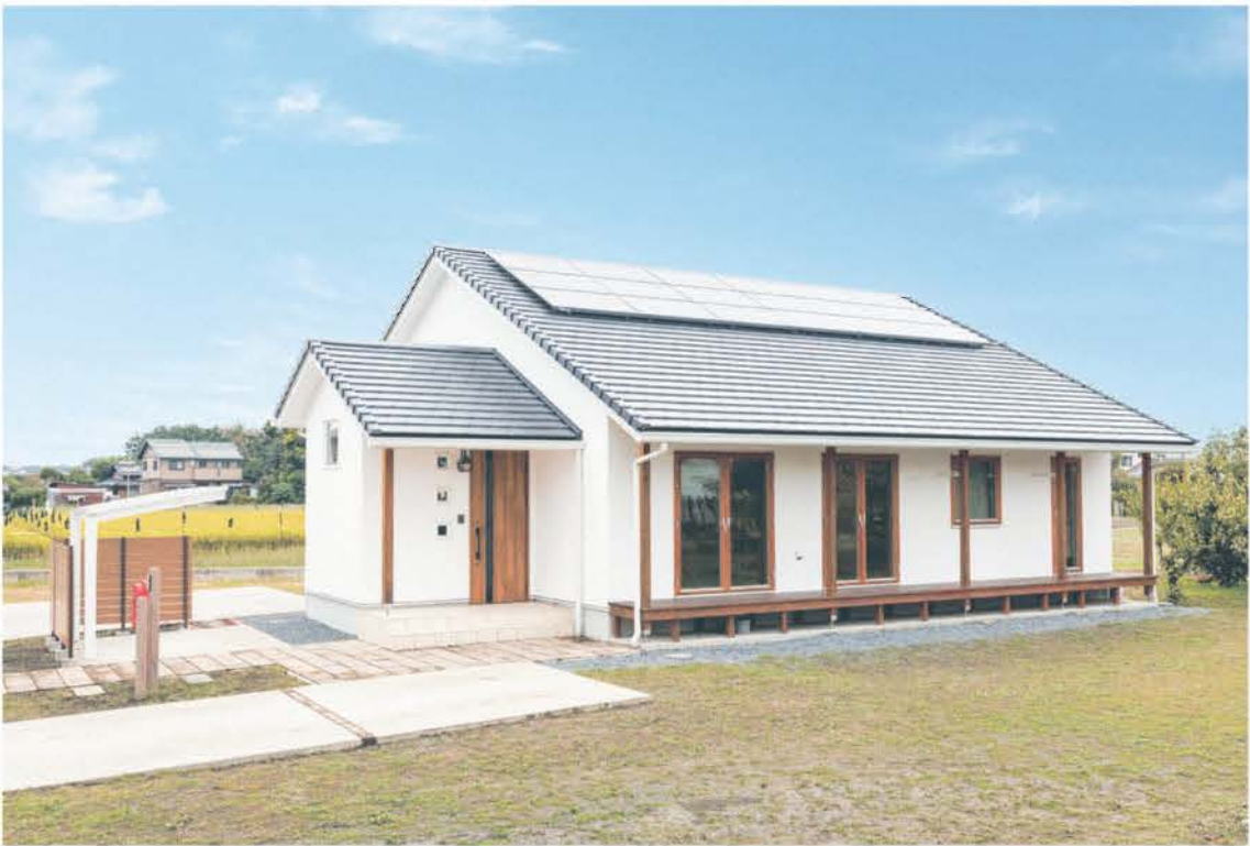
平屋を思わせる2階建て。おおらかな屋根に太陽光パネルを5.5kW搭載し、漆喰仕上げの外壁にウッドデッキや木製サッシが調和する。室内は開放感あふれるワンフロア。無垢の木と漆喰の塗り壁に満たされた空間は時と共に美しさを増し、家族が健やかに過ごせる家。
