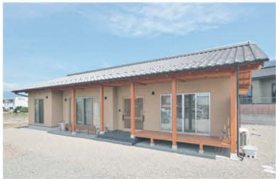
■ 塗り壁と本瓦に、垂木と縁柱。美しい和風の平屋
