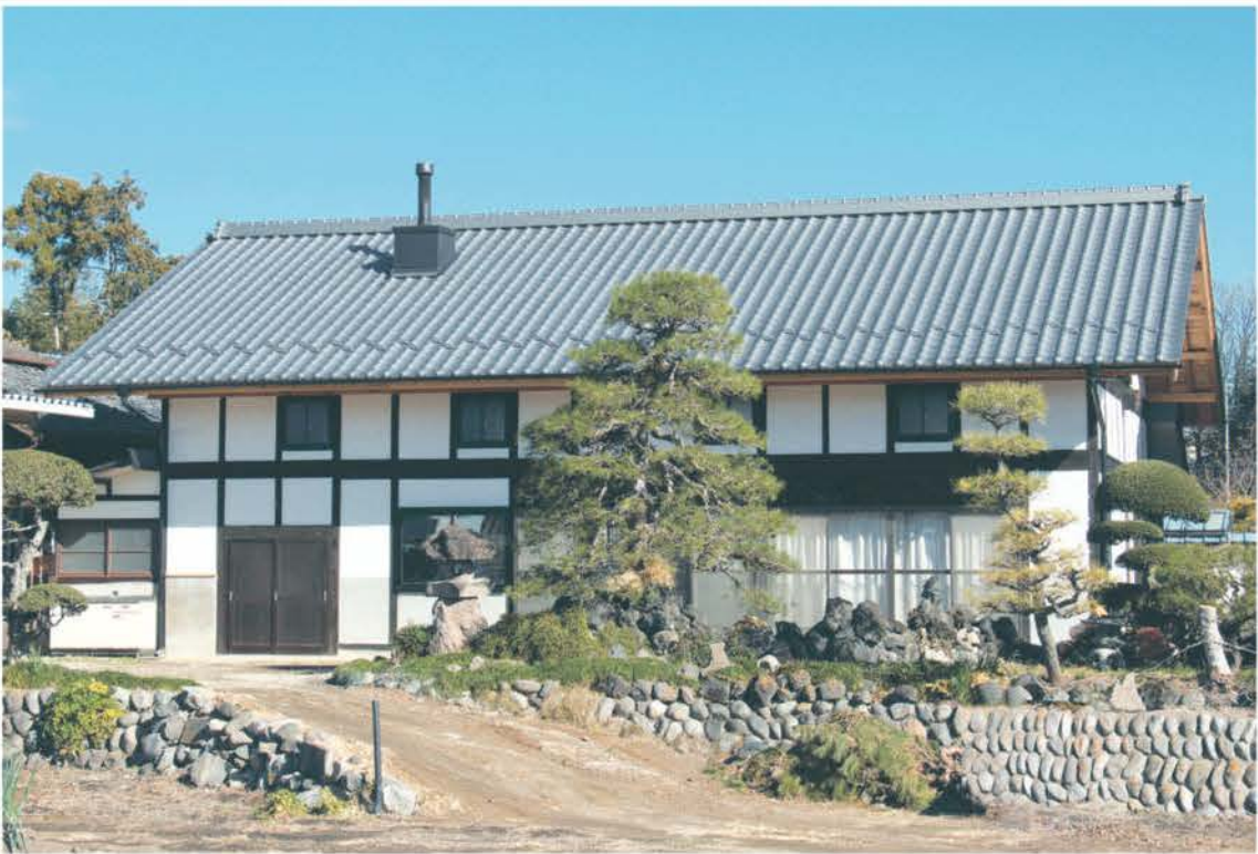
2階建ての古民家を住みやすいよう減築。神社仏閣の伝統的な黄金比を用いた外観は、端正な美しさを感じる。旧家屋で使用していた素材を「見栄えよく、格好よく、安定的に配するのが肝要」と丸山代表。漆喰の壁や現しの無垢の柱、日本瓦が見事に調和している
