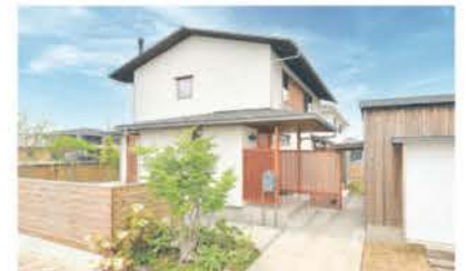
玄関への出入りがスムーズな板張りのガレージ
