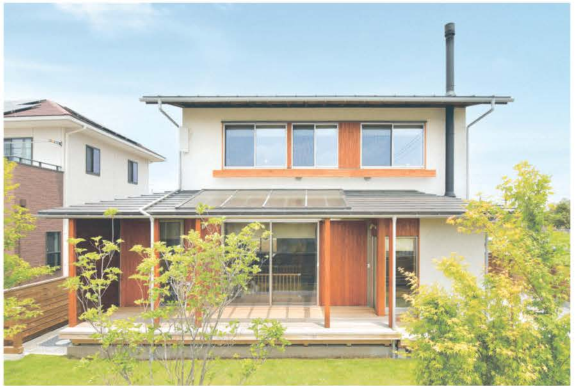
内外装ともに自然素材で満たされ、明るさと開放感を感じられる住まい。北側にガレージと玄関を配置し、吹き抜けのあるリビングを中心に動線が回遊。実面積以上の広がり創出する。「2022ぐんまの家」設計・建設コンクールにて最優秀賞を受賞。
