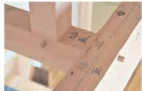
■ 木組みに残された墨付けの跡
