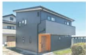
■ 外壁はガルバリウムを使用
