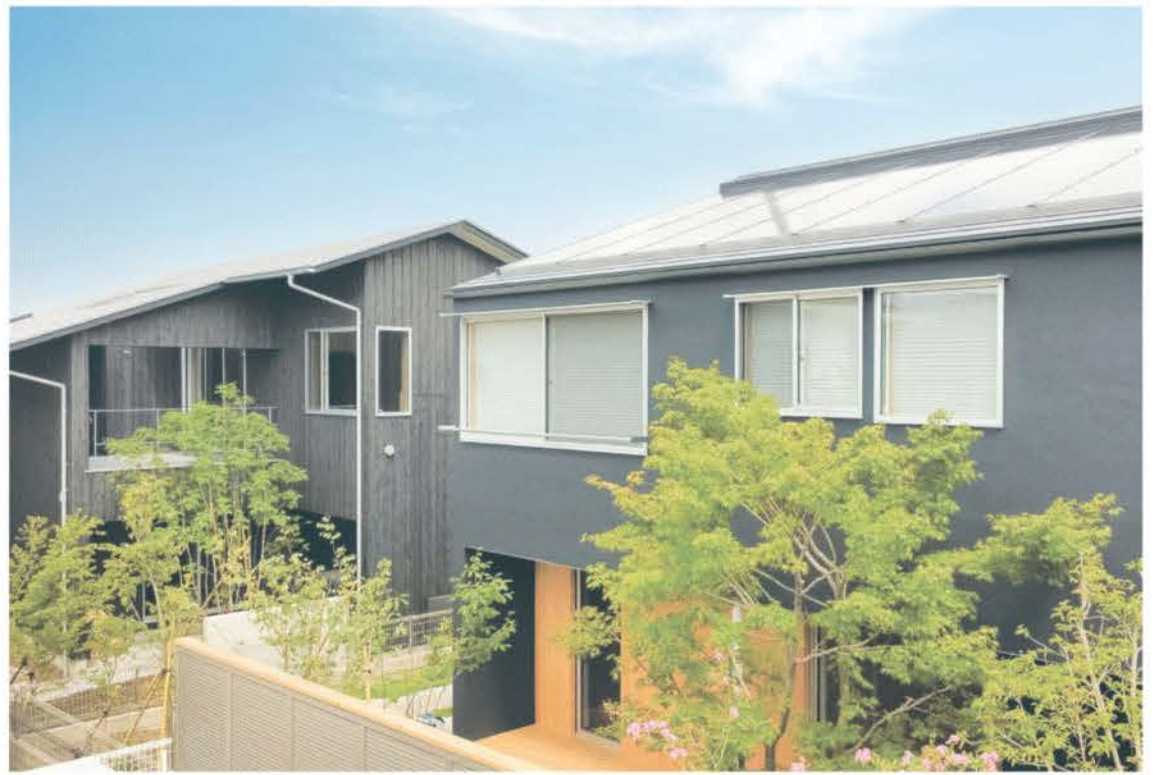
コンセプトの異なる2棟のモデルハウス。いずれも約50坪の敷地に最大3台の駐車スペースを確保。手前の「畳リビングの家」は和を意識した木質感あふれる総2階建て。「2階リビングの家」はリビングの延長にバルコニーが備わる。
