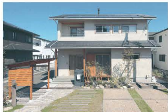
■ 深い軒とウッドデッキが庭とつながり、周辺環境に調和する外観
