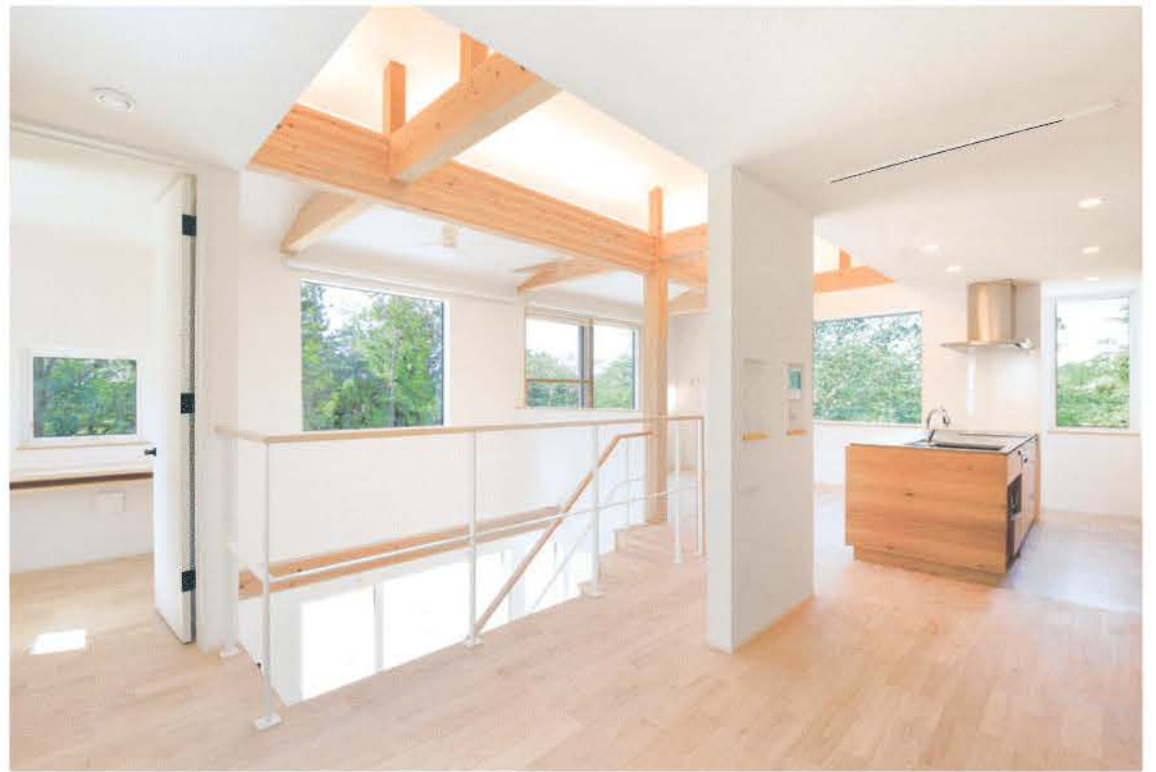
開放感あふれる2階リビングは開口の先に視線が抜け、明るさと豊かな緑を室内に取り込む。柱や梁は現し。床には栗の無垢板を張り、壁や天井には鎌倉漆喰を塗った。自然素材に満たされた居住空間。要所にアイアンや真ちゅうを用いた施主のこだわりが感じられる。
