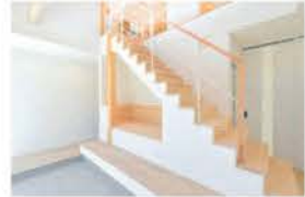
■ 階段下空間にベンチを造作
