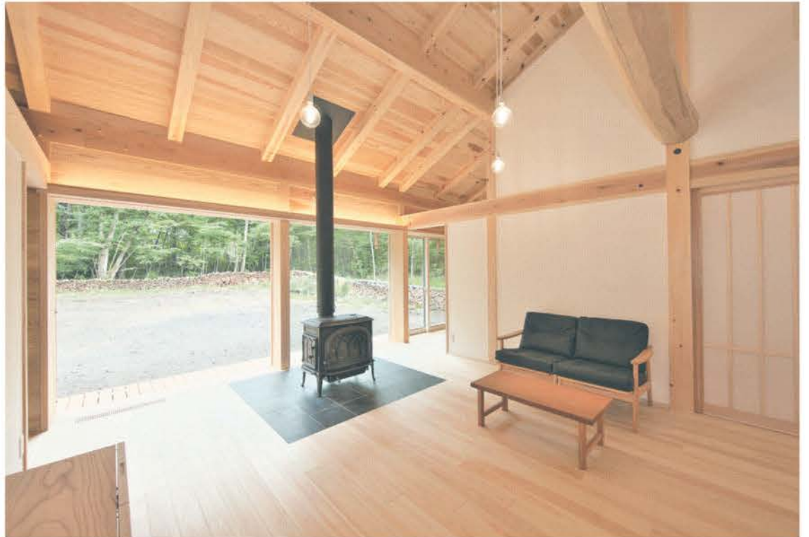
存在感のある栗の太鼓梁を渡し、力強い構造が現しとなった居室。家具や建具を造作し、無垢と漆喰に満たされた空間に薪ストーブが堂々と備わる。南面の大開口と縁側は庭と借景を存分に楽しめる。ワンフロアのLDKを中心に動線が回遊するシンプルな間取りの平屋
