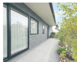
シックなモノトーンの外観。片流れの屋根に太陽光パネルを6枚搭載
