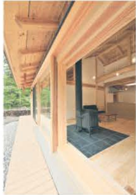
■大開口には木製サッシを採用
