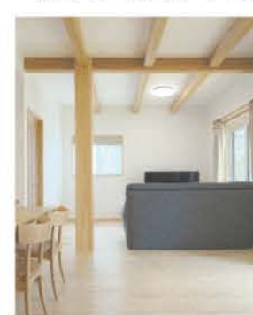
檜8寸角の大黒柱がワンフロアの空間をしっかりと支える
