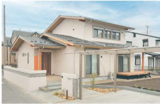
■塗り壁と、破風板や軒裏の色合いが調和のとれた外観
