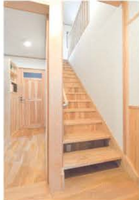
■縦張りの蹴込み板の階段
